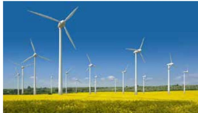
da torri alte 90 metri con tre pale rotanti, costruite in modo tale che la pressione del vento riesca a farle girare facilmente. In cima ad esse c'è un computer che cambia l'orientamento della turbina e delle pale per
