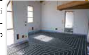
Impianti a pavimento
