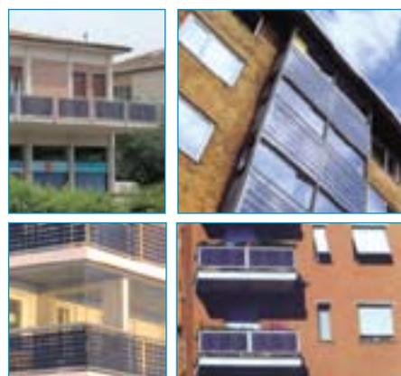
Realizzazione di balaustre, parapetti, ringhiere e recinzioni il cui materiale da costruzione sia sostituito con moduli fotovoltaici perfettamente integrati nelle loro strutture di sostegno.
