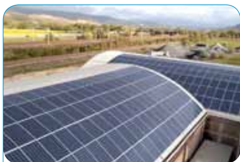
Cliente: ROMANA FARINE - Impianto a tetto di Kw 992,64 - Via dei Tessitori, Orvieto (TR)
